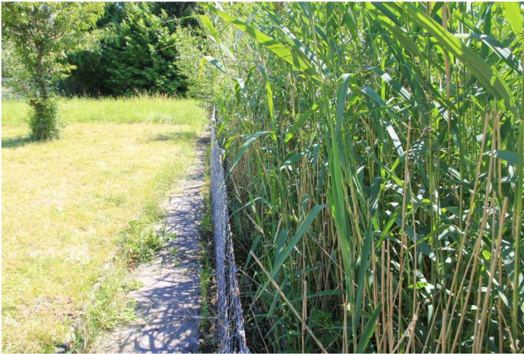
Foto 4: Heute wird das Ried gegen den Projektperimeter hin durch eine Betonmauer abgegrenzt. Für die Amphibien vom Ried her kaum überwindbar.
